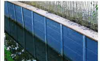
TRIMAX als Uferbefestigung
